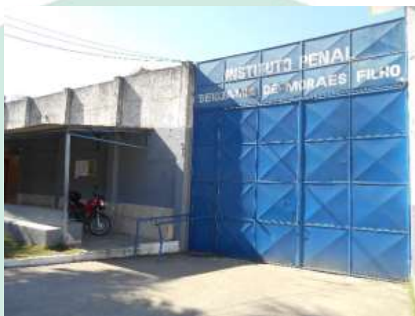
Figura 1 portões de acesso (registro em 20.07.18)
