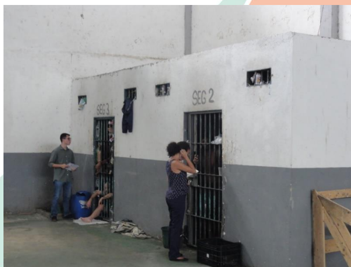
Figura 1 celas que foram demolidas
