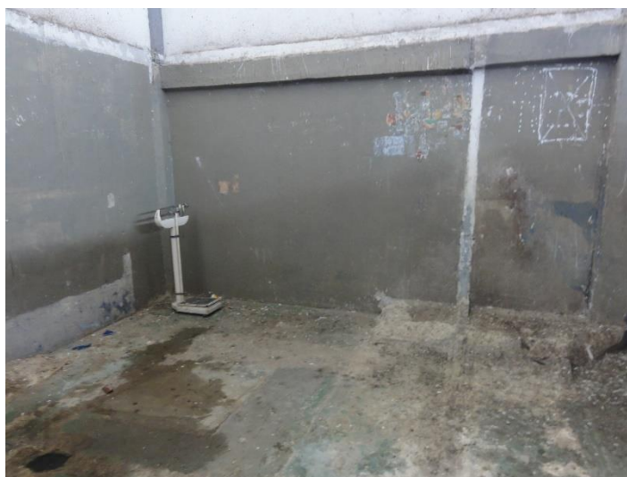
Figura 2 local onde ficavam as celas demolidas
